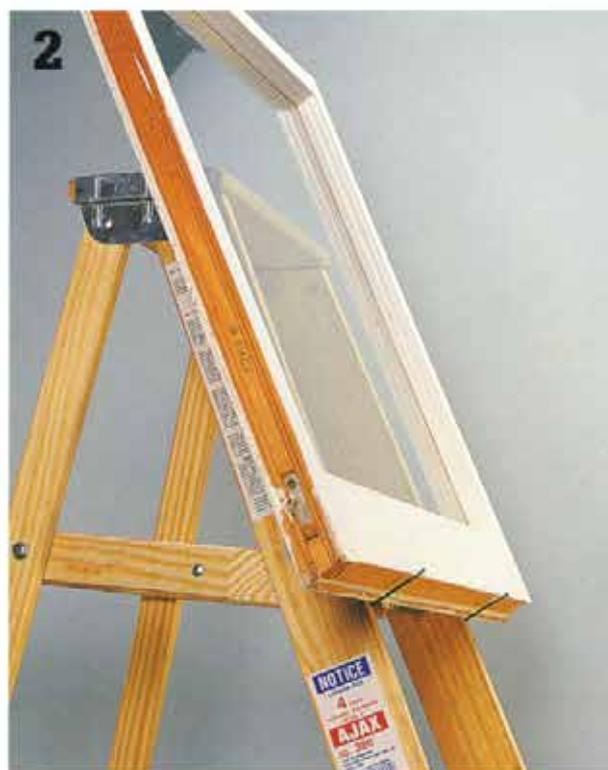
**Forez des trous et plantez deux clous** de 2 po dans les montants d'un escabeau. Placez la fenêtre comme sur un chevalet pour la peindre plus facilement, ou posez-la à plat sur un établi ou sur des tréteaux. Ne peignez ni les côtés ni la face inférieure des fenêtres à guillotine.
