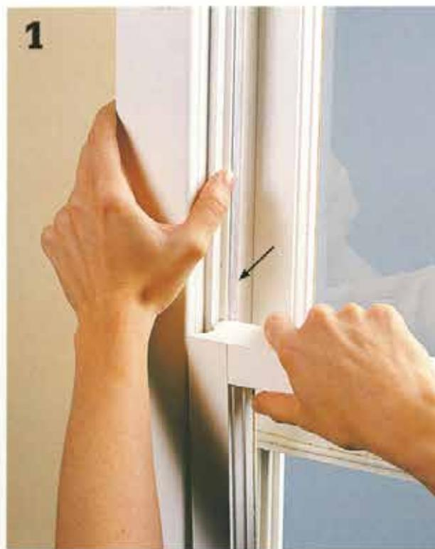
**Pour peindre les fenêtres à guillotine**, enlevez si possible la guillotine. On enlève les nouvelles fenêtres, montées sur ressorts, en appuyant simplement sur le châssis (voir la flèche).
