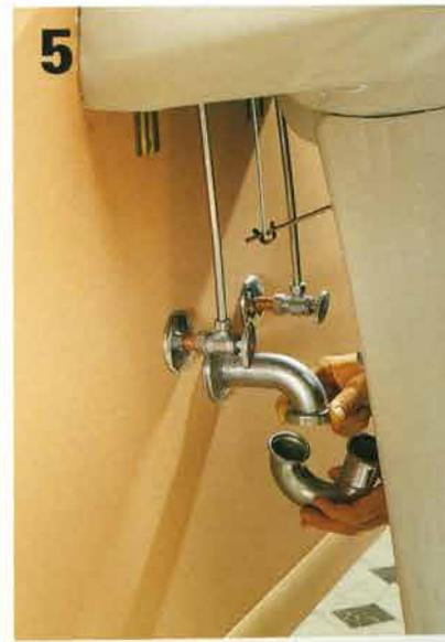
**Branchez les raccords** d'alimentation et d'évacuation. Appliquez un cordon de scellant pour former le joint entre le lavabo et le mur.
