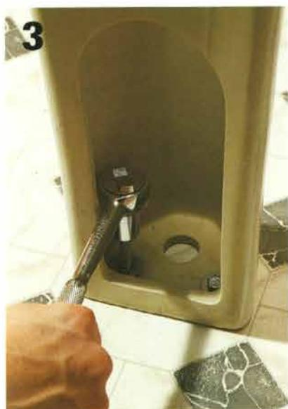
**Mettez de côté** le lavabo et son pied. Forez des avant-trous dans le mur et dans le sol, à l'endroit des marques. Remplacez le pied et ancrez-le au sol à l'aide de tire-fonds.
