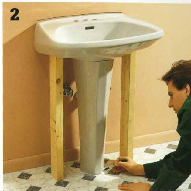
**Mettez le lavabo** et son pied dans la bonne position, et supportez le lavabo à l'aide de pièces de bois de 2 x 4. Tracez sur le mur une marque correspondant à la hauteur du lavabo; sur le sol, tracez le pourtour du pied. Marquez des points de repère sur le mur et sur le sol en faisant passer le crayon par les ouvertures pratiquées au dos du lavabo et sur la base du pied.
