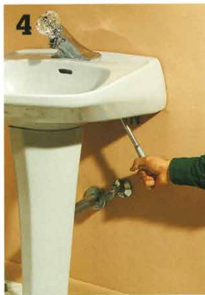
**Installez le robinet**, puis placez le lavabo sur le pied. Alignez les trous de montage à l'arrière du lavabo sur les avant-trous forés dans le mur. À l'aide d'une clé à douille à cliquet, vissez les tire-fonds avec des rondelles dans la traverse murale. Ne serrez pas trop les tire-fonds.
