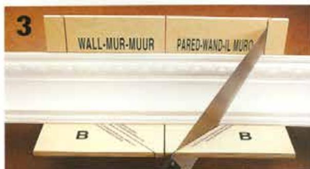
**3** **Pour effectuer les coupes en onglet des morceaux** formant le joint du premier coin, placez la moulure face vers le haut dans une boîte à onglets. Appuyez le côté «plafond» de la moulure contre la table horizontale de la boîte à onglets et le côté «mur» contre la cale-guide verticale. Faites la coupe à 45°.
