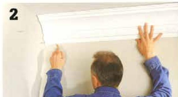
**2** **Tenez un morceau** de moulure contre le mur et le plafond, dans sa position définitive. Faites un léger trait de crayon vertical sur le mur, tous les 12 po, le long du bord inférieur du morceau. Enlevez le morceau et enfoncez partiellement un clou de finition à l'endroit de chaque trait. Ces clous supporteront la moulure en place pendant que l'adhésif séchera. Si le revêtement du mur est en plâtre, forez auparavant des avant-trous qui recevront les clous.
