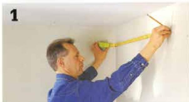
**1** **Organisez la disposition** des morceaux de moulures en mesurant les murs de la pièce et en faisant de légères marques là où tomberont les joints. En prévision des chutes, ajoutez 12 à 24 po à chaque morceau partant d'un coin ou y aboutissant. Évitez si possible les morceaux de moins de 36 po, plus difficiles à ajuster.
