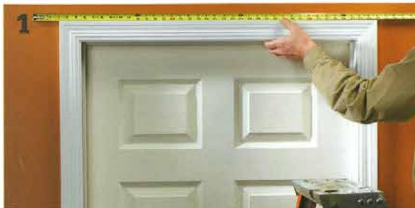
**Coupez une moulure** de lit ou une moulure couronnée à une longueur approximativement égale à la largeur de l'encadrement de la porte, plus 6 po. Sur le bord inférieur de la moulure, faites des marques de coupe aux points correspondant à la largeur de l'encadrement. Commencez les marques à 2 po de chaque extrémité pour pouvoir couper les extrémités en onglet.
