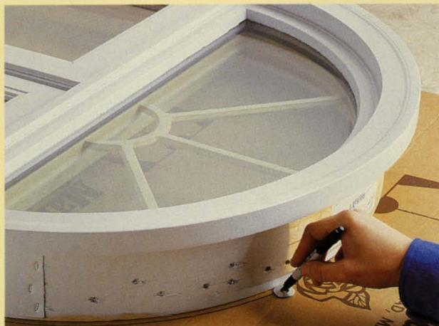
**Fabriquez un gabarit** qui vous aidera à tracer le contour de l'ouverture sur le revêtement mural. Tracez le contour du cadre arrondi sur du carton, en y ajoutant  $\frac{1}{2}$  po, pour pouvoir effectuer les ajustements nécessaires dans l'ouverture, le moment venu. Une rondelle métallique de  $\frac{1}{4}$  po x  $1 \frac{1}{4}$  po est tout indiquée pour tracer ce contour. Découpez le gabarit en suivant la ligne que vous avez tracée.
