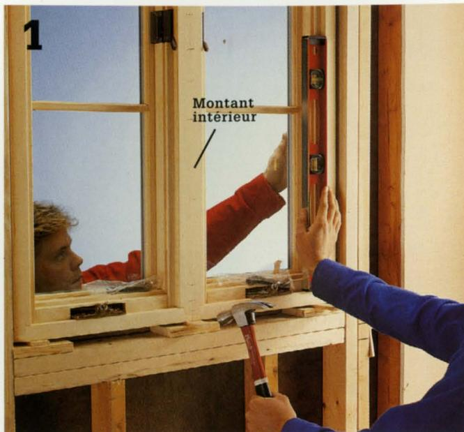
**1** **Enlevez le revêtement mural extérieur**, puis essayez la fenêtre, en la centrant dans l'ouverture. Supportez-la au moyen de blocs de bois et d'intercalaires placés sous la traverse de base. Vérifiez si la fenêtre est d'aplomb et de niveau et faites les ajustements nécessaires, le cas échéant.
