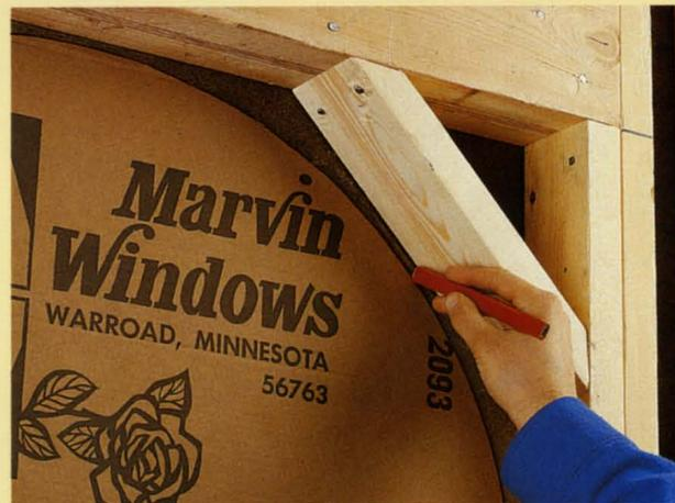
**Collez le gabarit** sur le revêtement mural, en accolant le sommet du gabarit au linteau. En vous basant sur le gabarit, installez des éléments d'ossature inclinés dans les coins de l'ouverture. Ces éléments doivent juste toucher le bord du gabarit. Tracez le contour du gabarit sur le revêtement, pour pouvoir découper l'ouverture.
