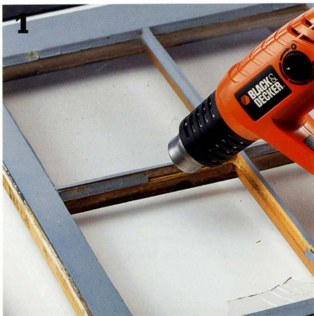
**Après avoir enfilé d'épais gants de cuir,** retirez les tessons. Puis, ramollissez le vieux mastic à l'aide d'un pistolet à air chaud ou d'un séchoir. Ne maintenez pas le pistolet à air chaud trop longtemps au même endroit, car il peut être assez chaud pour faire roussir le bois ou faire craquer les carreaux adjacents.
