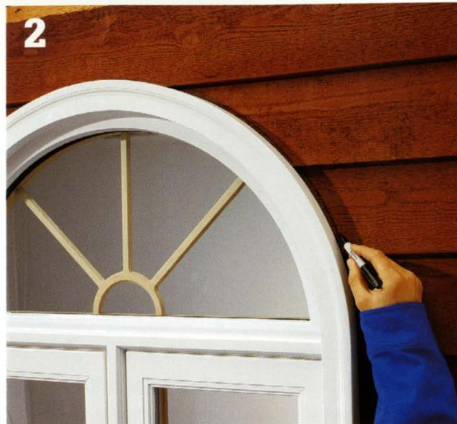
**2** **Tracez le contour du chambranle** sur le bardage. **NOTE:** Si le bardage est en métal ou en vinyle, élargissez le contour pour disposer de l'espace nécessaire à l'installation de la moulure en J supplémentaire qu'exigent ces types de bardages. Enlevez la fenêtre après avoir tracé le contour.
