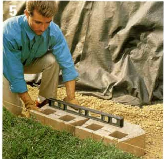
**Posez la première rangée de blocs** en alignant leur bord avant sur le cordeau de maçon. (Si vous utilisez des blocs bridés, retournez les blocs de la première assise et placez-les de manière que la bride soit à l'avant.) Vérifiez régulièrement le niveau de l'assise et corrigez-le si nécessaire en ajoutant ou en retirant de la pierre concassée à l'endroit où reposent les blocs.
