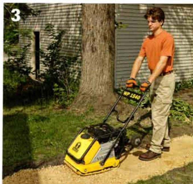
**Déposez une couche de 4 po de gravier compactable**, que vous tasserez au moyen d'un compacteur à plaque. Ajoutez encore 4 po de gravier. Passez la planche à araser sur la surface, en vérifiant avec l'indicateur si la pente est ou non adéquate. Compactez le gravier pour que sa surface se trouve à 4 po de la surface de l'allée finie. Réglez les cordeaux à la hauteur exacte de l'allée finie.
