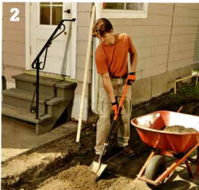
**Creusez le sol** en fonction d'une sous-couche de 6 po de gravier et de l'épaisseur de la partie de dalle qui se trouvera sous le niveau du sol. Mesurez la profondeur à l'aide d'un poteau de référence placé contre le cordeau le plus élevé, puis servez-vous d'un indicateur de pente pour créer la pente. Foulez bien le sol à l'aide d'un compacteur à plaque.
